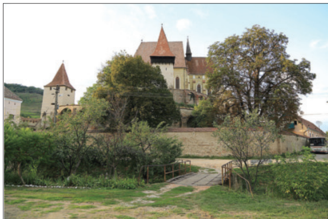
Die Brücke über den Reichesdorfer Bach kurz vor dem Zusammenfluss mit dem Blechbach (2012)
