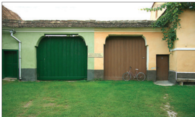
Die Wasserstandsmarke an der Wand zwischen den Toren (2008) Foto: Karl Schuller
