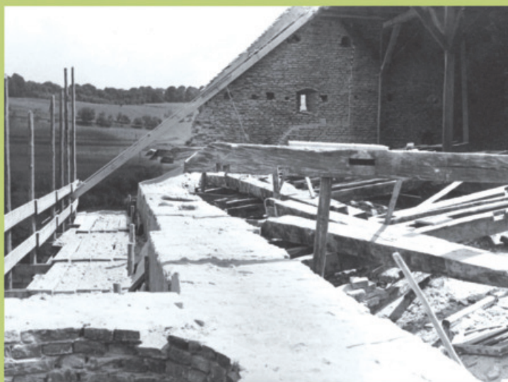
Auf diesem Foto erkennt man den gemauerten Giebel, der sich zwischen dem Dach des Langhauses und dem Chordach befindet und der im Zuge der Renovierungsarbeiten abgetragen wurde, um durch ein Fachwerk mit Dachziegelverkleidung ersetzt zu werden. Vorne links sieht man die Öffnung der Wendeltreppe des nördlichen Türmchens. Im Hintergrund erstreckt sich der Hirsberg.
