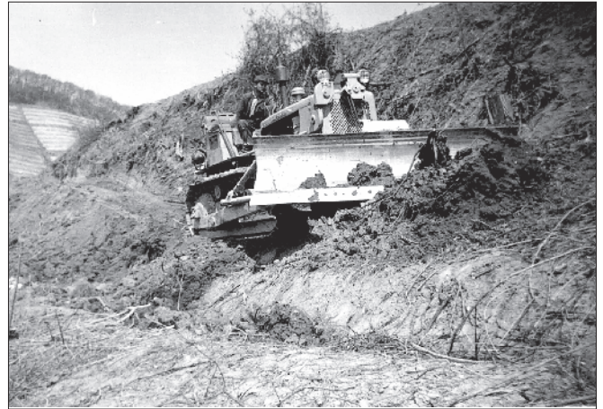
Arbeiten an den Berghängen
