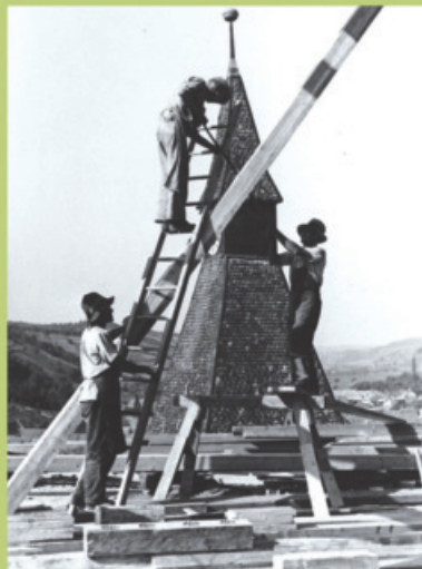
Montage des Dachstuhls. Im Hintergrund erblickt man das Dach des Stundenturms.
